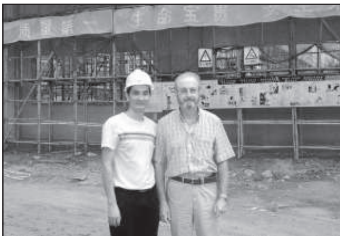
Fàbrica en construcció a Kaiping (Xina)
