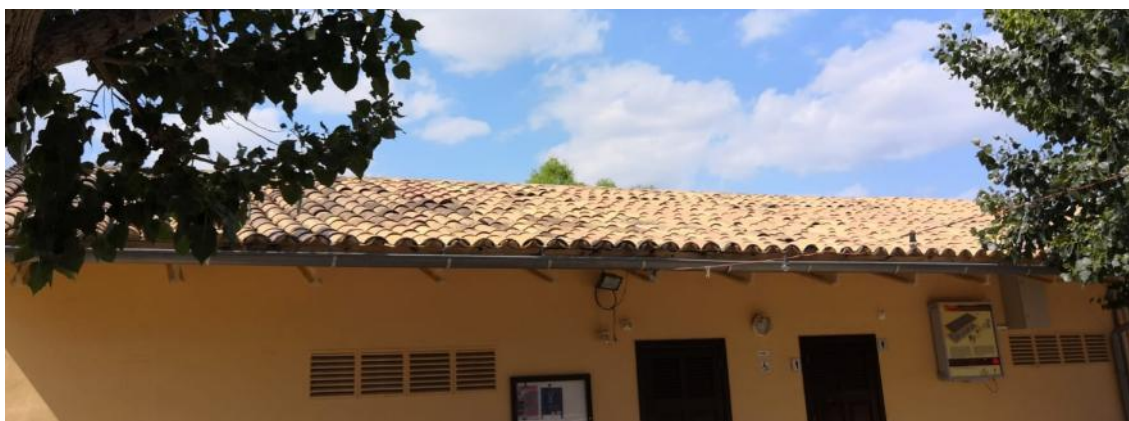
Imatge 30. Detall possible superfície destinada a instal·lar fotovoltaica autoconsum.
