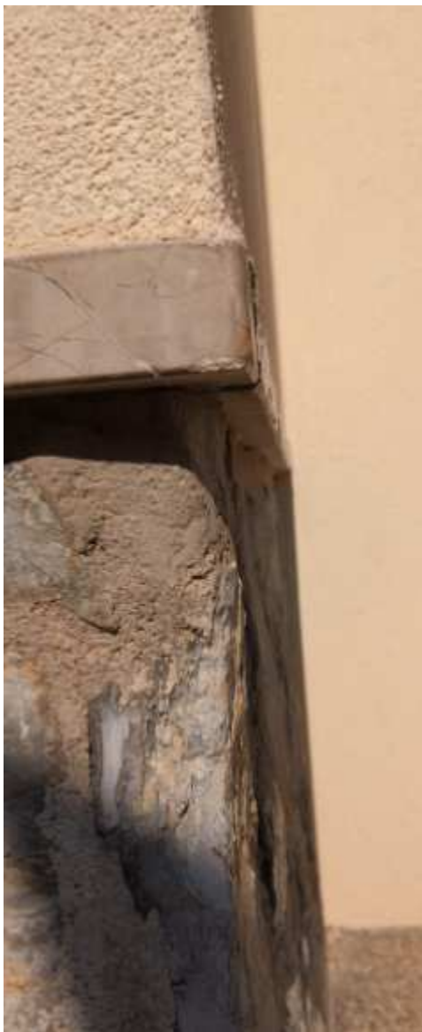
Imatge 14. Detall aïllament.
