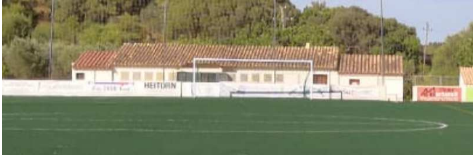
Imatge 14. Vista general de l'edifici de vestuaris.
