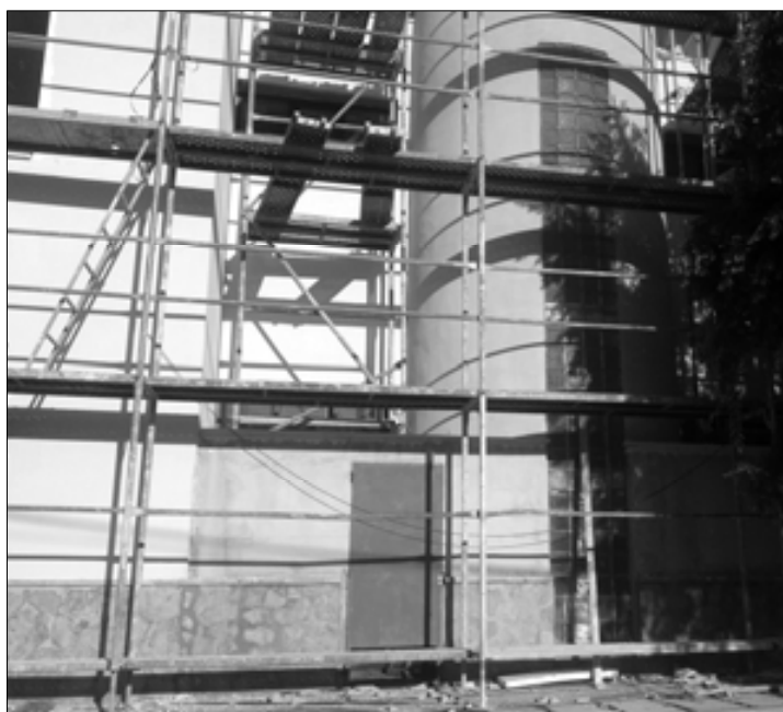
L'escola en obres
