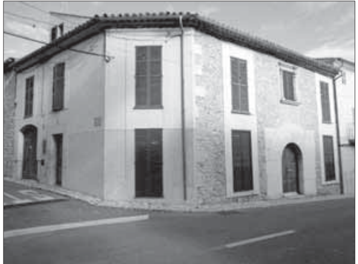
La Casa de la Vila, anys trenta, ubicada al Primer pis, cantonada carrers Principal i Salvador Beltran.
