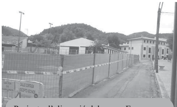
Projecte d'alineació del carrer Es Pedregaret i millora de zona esportiva. Pressupost: 333.500 € Pla d'Obres i Serveis Consell de Mallorca
